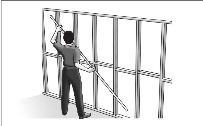
FIGURE 1 FRAME STRAIGHTNESS
